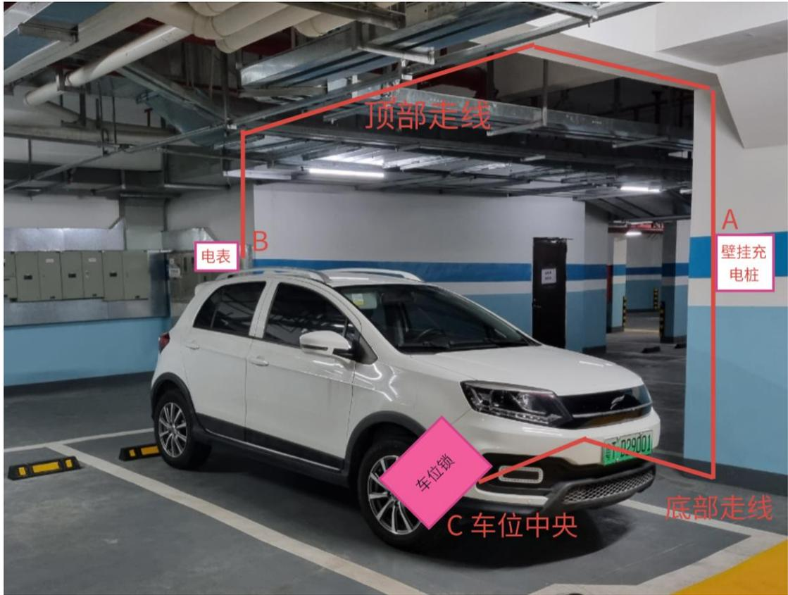
③安装固定通过 3M 胶固定在车位中央，无破坏防水层风险
